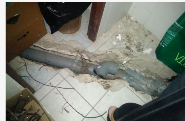
OBR 1.2 Kanalizace v přízemí penzionu P, stav červenec 2019 (Zdroj: foto Jana Prattingerová)
